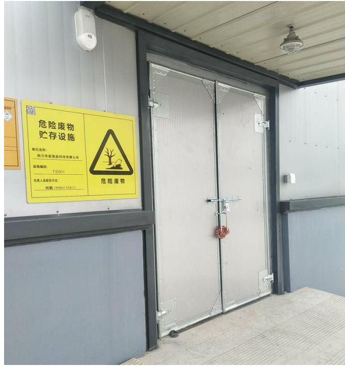
图 4.1-4 危险废物暂存间
